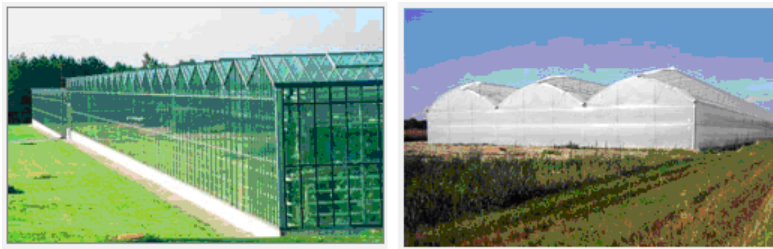
Figura 4.9 Sere: a. - cu anvelopa din sticlă, b. - cu anvelopa din peliculă de polietilenă.
